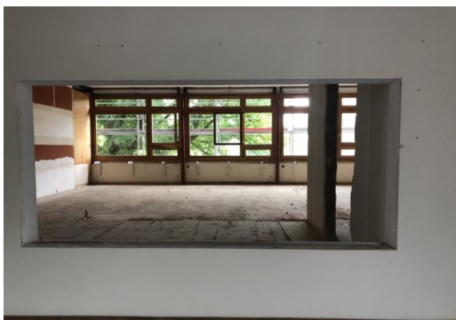
Das Lehrerzimmer und die Aula im Umbau
