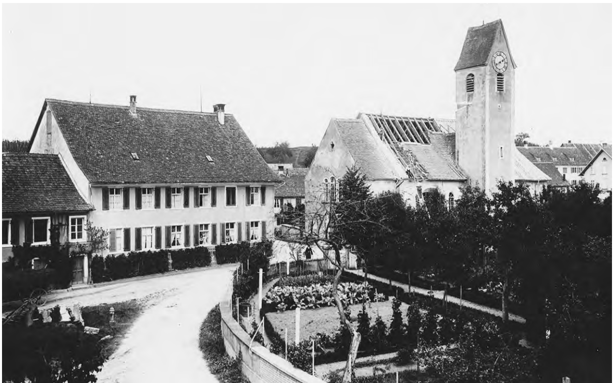
Abb. 22: Blick über die Kirchgasse zur reformierten Kirche. Im Vordergrund der Pfarrgarten. [KDP]
